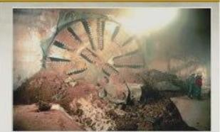
La vía del metro, de 23 km será subterránea construida en un túnel de 9,43 m de diámetro con máquinas tuneladoras o escudos de presión. Si la tuneladora encuentra un terreno poco consolidado se expande porque administra presión del entorno.
